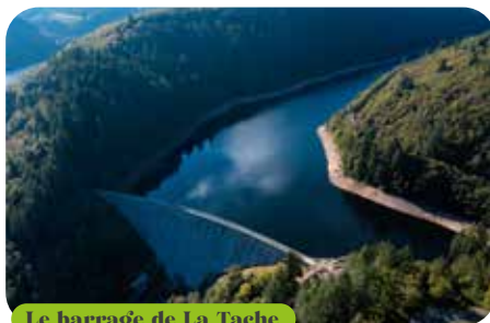
Le barrage de La Tâche
